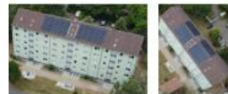
Abb. 59 und 60. Gebäude mit PVT-Anlage auf dem Dach in Ost- West Aus- richtung.
