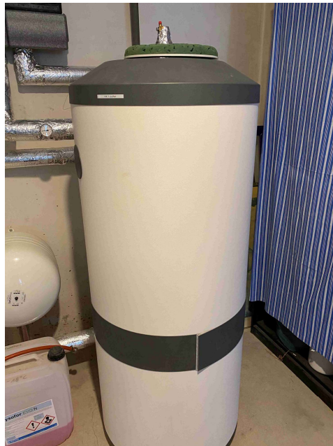
Wärmepumpe mit Pufferspeicher
