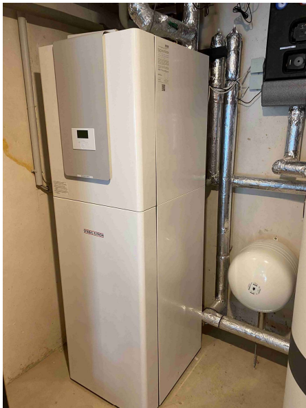
Wärmepumpe mit Pufferspeicher
